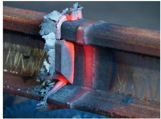
รูปที่ 18 แนวเชื่อมเมื่อตัดเศษออกด้วยเครื่องตัดเฉพาะ [6]
