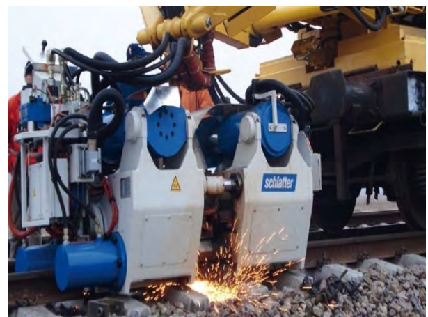
รูปที่ 15 เครื่องเชื่อมต่อนเคลื่อนที่บนรางรถไฟ [6]
