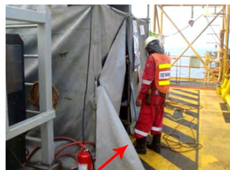
Fire Watch Man เฝ้าระวังไฟตลอดเวลาทำการเชื่อม และปฏิบัติงานที่มีความร้อน
