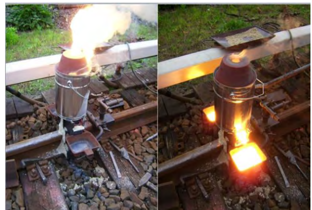
รูปที่ 12 ขั้นตอนของการเชื่อมเทอร์มิต [6]
