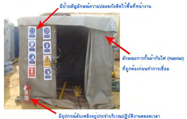
รูปที่ 17 ลักษณะการกันผ้ากันไฟ (Habitat) ที่ถูกต้อง และการจัดพื้นที่ทำงาน
