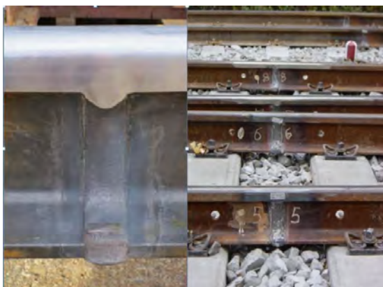
รูปที่ 13 แนวเชื่อมเทอร์มิตหลังจากติดตั้งแนวแล้ว [6]
