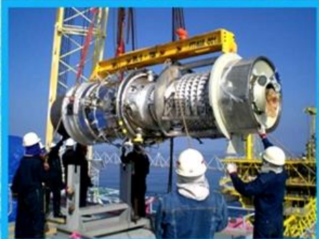
ประกอบเครื่อง Turbine Compressor
