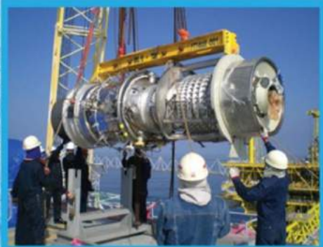
ประกอบเครื่อง Turbine Compressor
