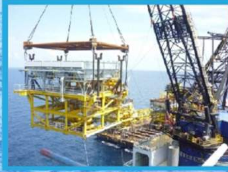
ติดตั้งระบบเพิ่มแรงดัน NGV ที่อ่าวไทย
